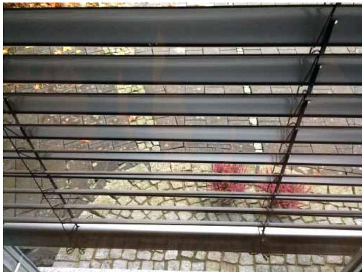
Bei rechtwinkliger Draufsicht auf die geschlossenen Lamellen darf keine Durchsicht möglich sein.
